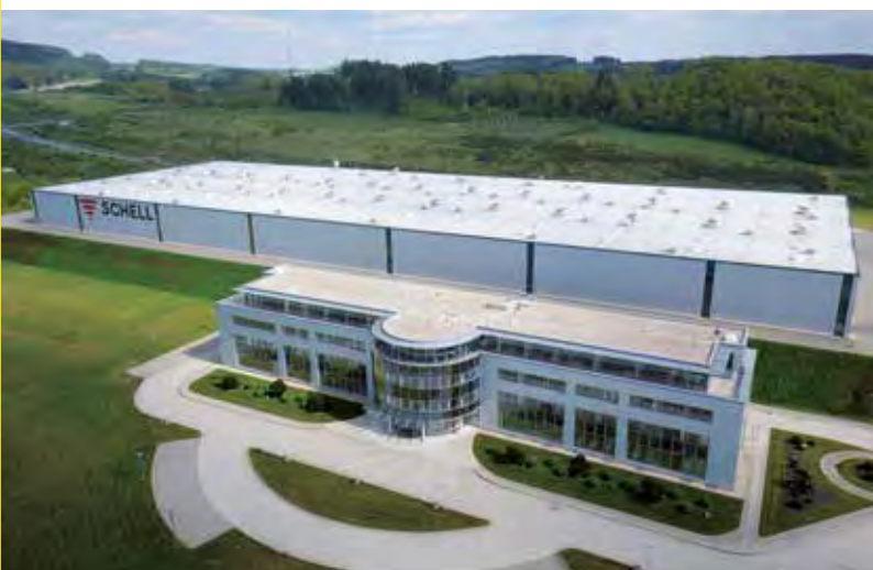
Werk 1 Produktion mit Verwaltungsgebäude und Schulungszentrum
