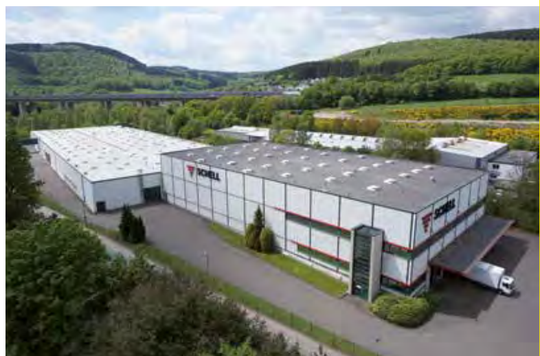
Werk 2 Produktion mit Logistikzentrum
